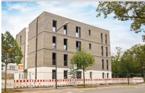
Öffentlich geförderter Wohnraum wird dringend gebraucht. In Würzburg entstanden in nur acht Wochen zwei viergeschossige Gebäudekomplexe mit insgesamt 24 Wohneinheiten in Hybridbauweise. Dabei kamen Holzständerwände in Kombination mit vorgefertigten Betonfertigteildecken der Dennert Baustoffwelt zum Einsatz – das eröffnet gerade im Objektbau ganz neue Möglichkeiten. (s. Beitrag S. 6; Foto: Dennert)
