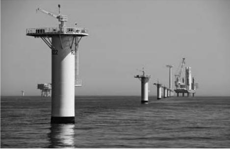
*In nur 14 Monaten Bauzeit errichtete EWE vor der Küste Borkums mit „Riffgat“ den ersten kommerziellen Meereswindpark in der Nordsee. Jede der 30 Windkraftanlagen hat eine Leistung von 3,6 MW bei einem Rotordurchmesser von 120 m. Die Verankerung im Meeresboden erfolgte mit bis zu 70 m langen und bis zu 720 t schweren Pfählen („Monopiles“), die in den Grund eingerammt wurden (s. S. 68).*
