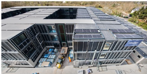
Bis der Neubau des Gymnasiums Mainz-Mombach fertig ist, dient ein Interim-Modulbau als Lernort
