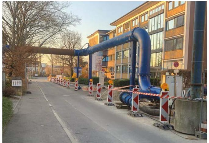
**Bild 2** Das anfallende Mischwasser wird während der Sanierungsarbeiten über aufgeständerte Druckrohrleitungen DN 800 abgeleitet.
