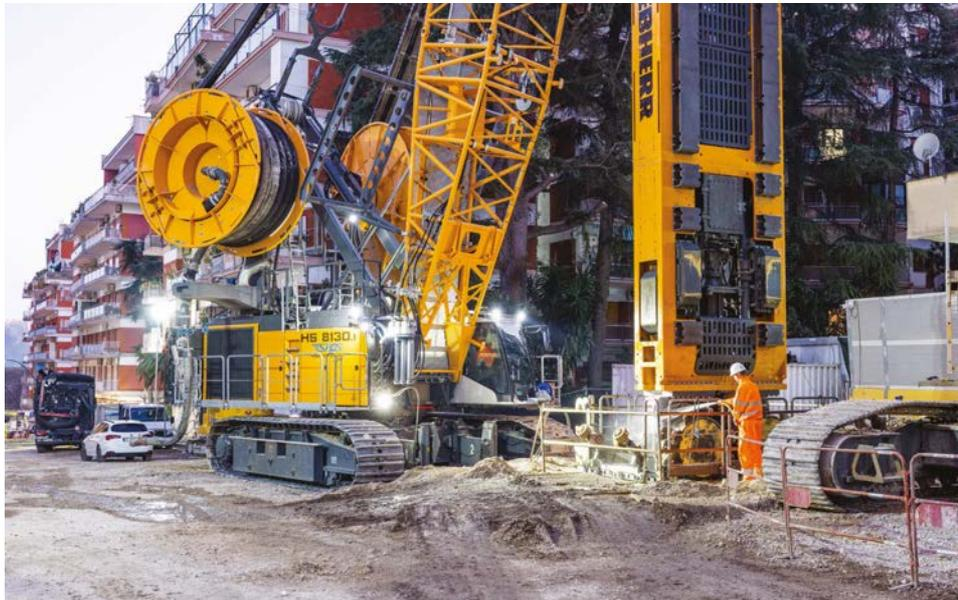
**Bild 1** Der leistungsstarke HS 8130.1 von Liebherr ist bestens für Schlitzwandaarbeiten geeignet.
