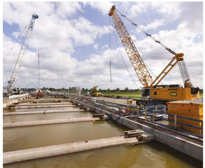
**Bild 3** Die kombinierte Startbaugrube für Tunnelvortrieb und unterirdische Gebäude ist ca. 1500 m<sup>2</sup> groß.
