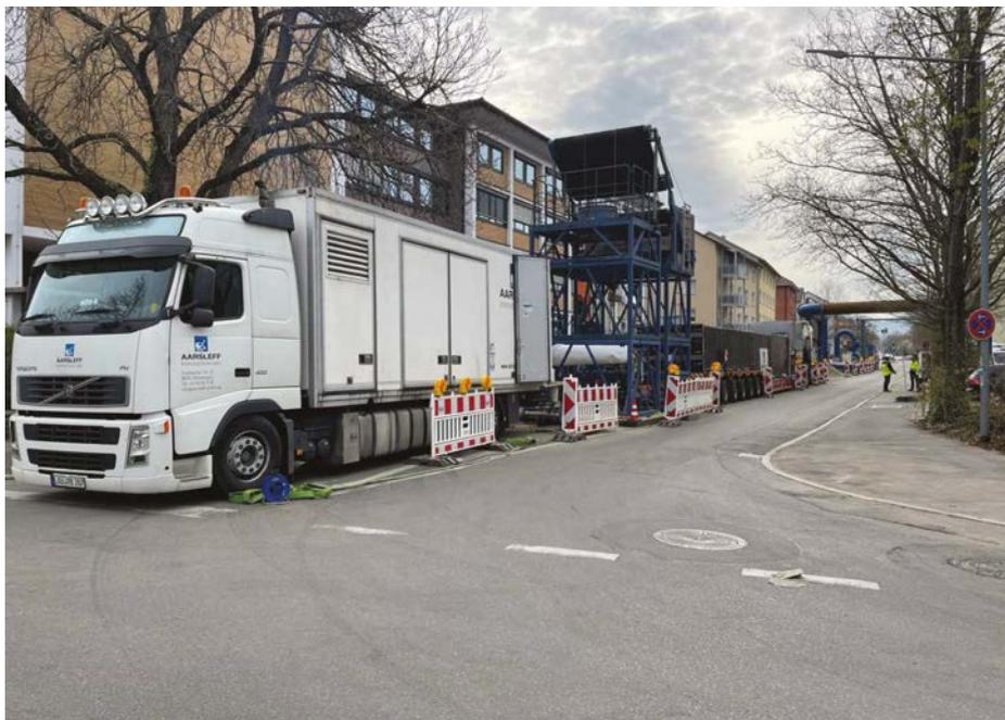
**Bild 1** Von der Bismarckstraße aus wird der Liner in den Mischwassersammler in der Bahnhofstraße invertiert. Das hat den Vorteil, dass der Inversionsturm sowie der Schwertransporter mit dem Synthesefaserliner in der Bismarckstraße Platz finden und den Verkehr in der Bahnhofstraße kaum beeinträchtigen.
