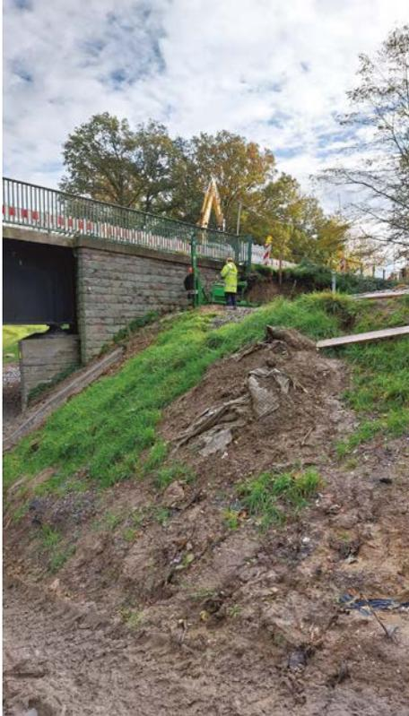
**Bild 3** Bodensondierung mit der Sondierdraupe MRZB von Carl Hamm Geotechnik
