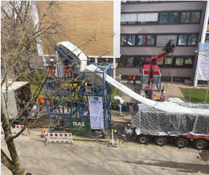
**Bild 3** Der Synthesefaserliner wird am Inversionsturm befestigt und mittels Wasserdruck in den Kanal hineingestülpt. Damit der Liner nicht vorzeitig härtet, wird er für den Transport mit Eis gekühlt.
