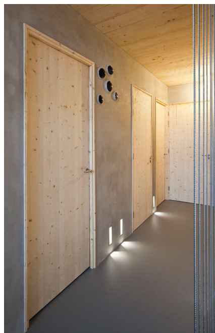
Bild 2 Im modernen, nachhaltigen Innenausbau kommen Lehmplatten zum Einsatz. Sie sind schadstofffrei, nicht brennbar und beugen Schimmelbildung effektiv vor.
